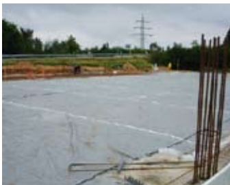
▲ Vorbereitung fürs Betonieren
