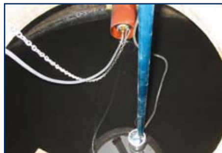
▲ Während der Dichtheitsprüfung Verschluss des Systems mittels Druckblase
